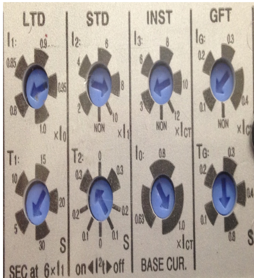
**شکل ذیل واحد های مختلف رله الکترونیکی را نشان می دهد.
